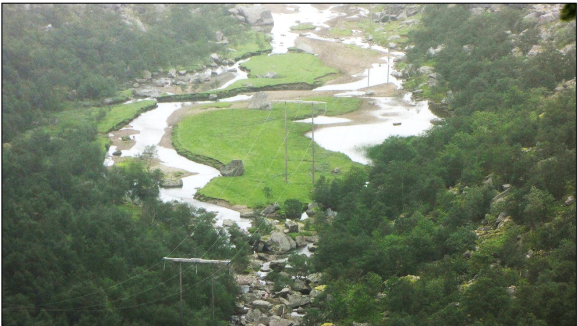
Figur 4. Området der kraftstasjon planlegges på kote 100 sees midt i bildet der kraftlinja krysser elva. Bildet er noe uklart på grunn av regn. Foto: Geir Arnesen.
